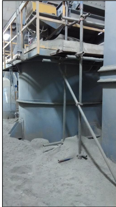
Gambar 3.2 Material yang keluar dari flexible joint dan tercecer di lantai
