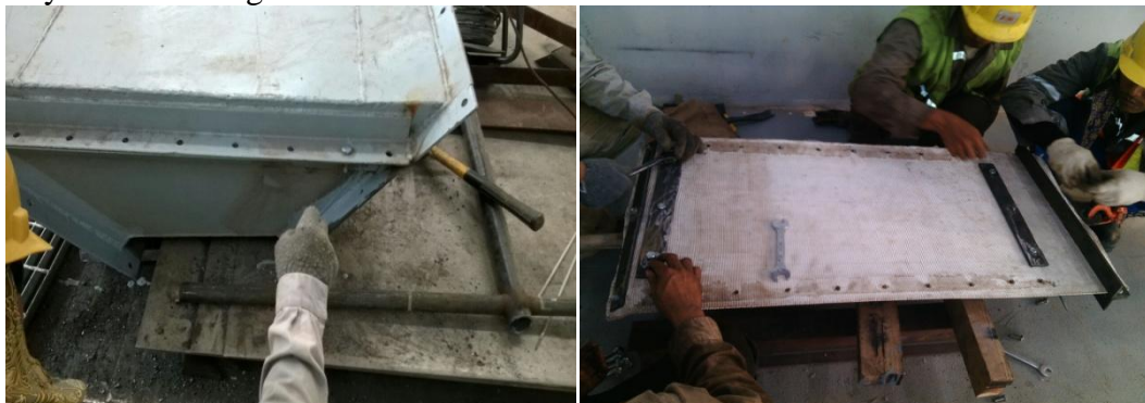
Gambar 3. Fabrikasi Airslide
