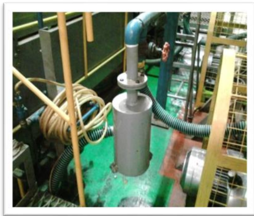
Gambar 2. Separator oli Tabel 3. 1 Spesifikasi bahan separator oli
