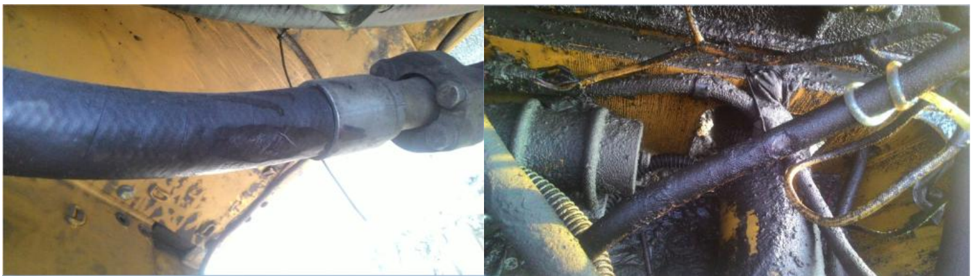
Gambar 5. Kesalahan Posisi Pemasangan Hose
