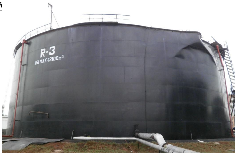
Gambar 3. Kerusakan Tangki R-3 akibat Overpressure
