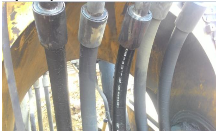
Gambar 6. Rembesan Pada Fitting Hose
