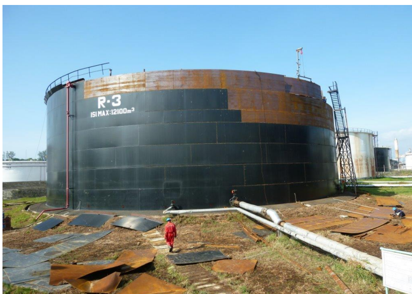
Gambar 4. Perbaikan kerusakan Tangki R-3
