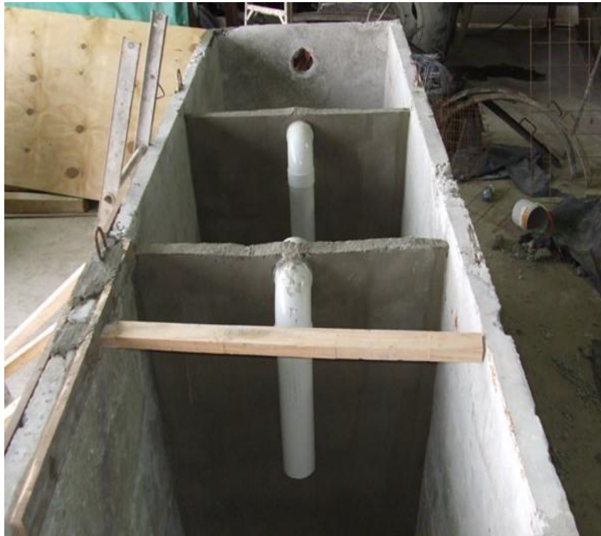
Gambar 4. Konstruksi oil trap sederhana.
