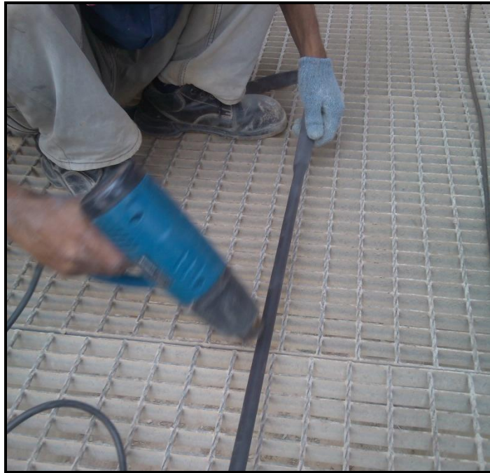
Gambar 4 Proses Pelapisan Heat Shrink Insulation pada Rod Probe
