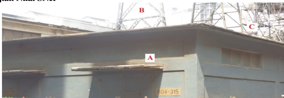
Gambar 3. Lokasi pengujian wireless
