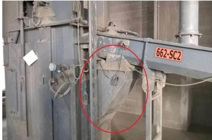
Gambar 2. Material semen reject yang keluar dari outlet Screw Conveyor
