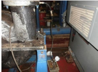
Gambar 3.6 Proses pemasangan alat tes
