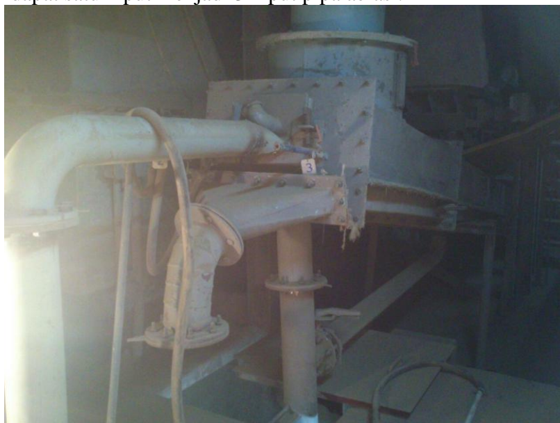
Gambar 3 564-AS1 setelah dilakukan modifikasi pada input pipa aerasi
