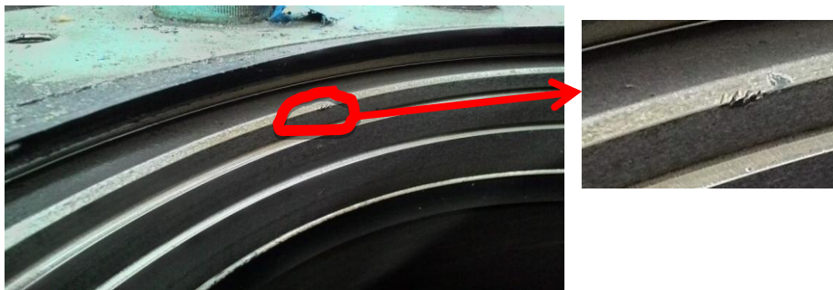
Gambar 8. Coakkan pada Main Cylinder
