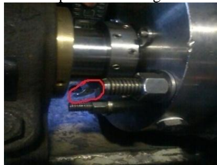
Gambar 3.25 Kebocoran pada mech. Seal
