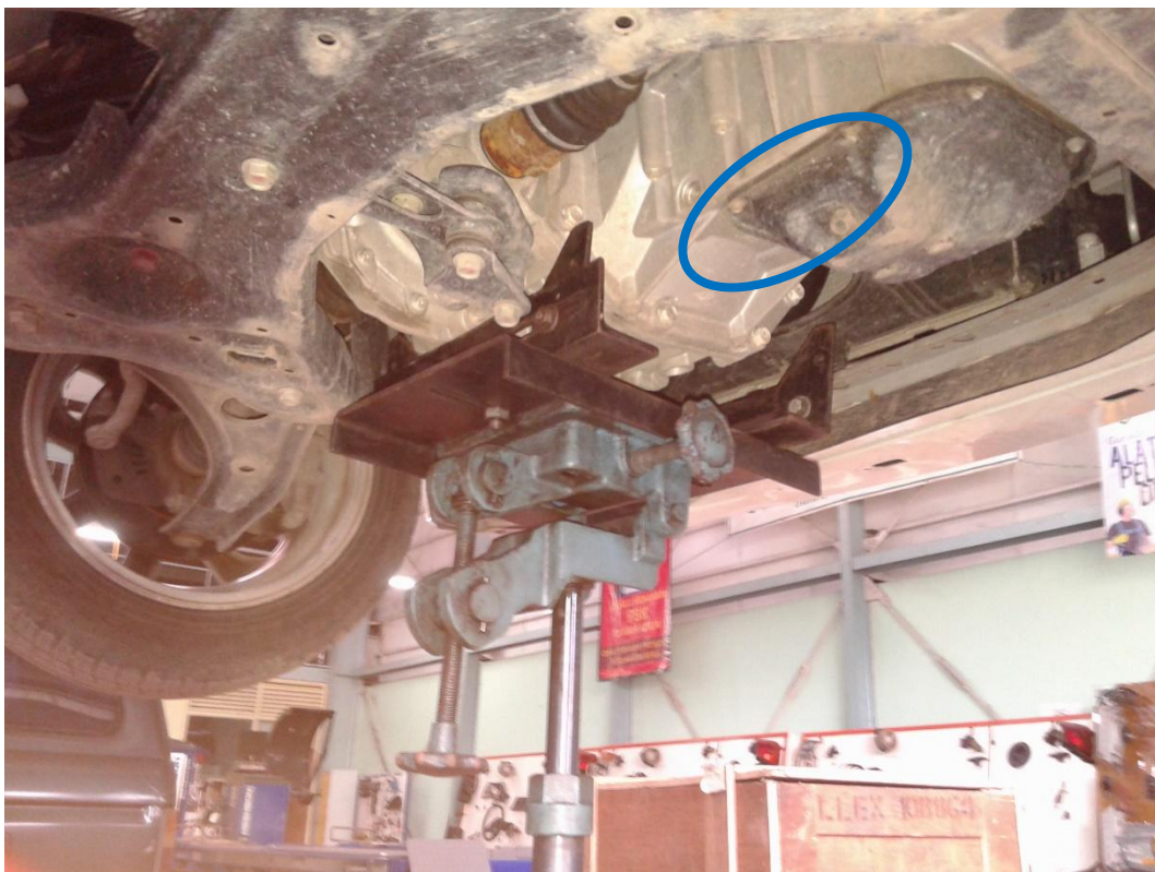
Gambar 2. Tidak adanya alat Penahan Engine ( Engine Holder )
